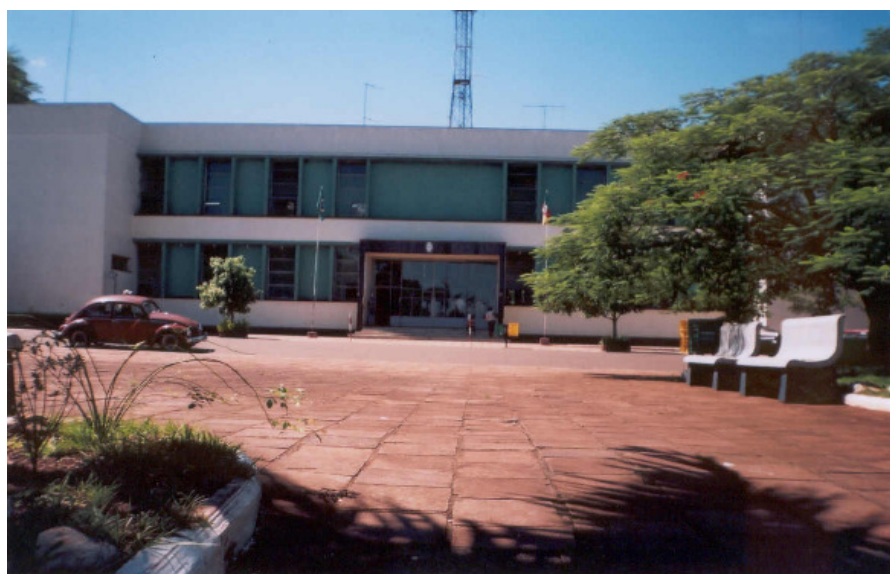
PREFEITURA MUNICIPAL DE SANTO CRISTO, JUNTO À PRAÇA WOLFRAM METZLER (COORDENADAS: N° 729.777 E 6.920.312)
